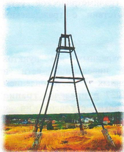
Геодезический пункт - инженерная конструкция, закрепляющая точку земной поверхности с определенными координатами.
